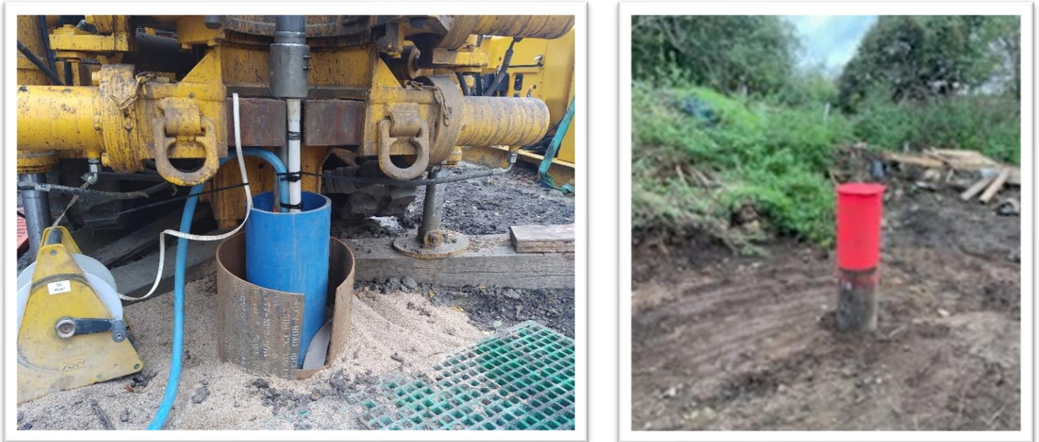
Figure 3 : Photographies de la tête de forage avant et après intervention
