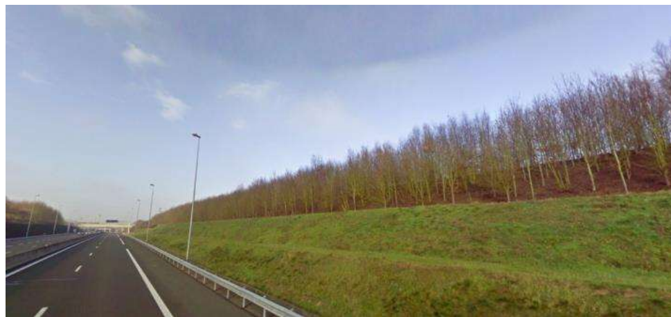
Vue sur le sous-secteur Nord depuis l'autoroute A14 (partie Ouest) – photo janvier 2011
