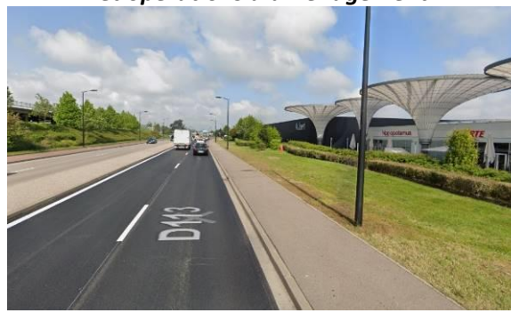
Un paysage requalifié grâce à des actions et opérations d'aménagement
